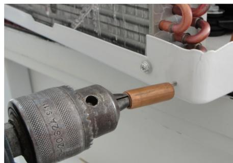
**ATENÇÃO:** Utilizar um tubo de cobre de ½" no corpo da broca como limitador para que ao realizar a furação, a mesma não ultrapasse e danifique a tubulação do trocador de calor. É importante ter cuidado para não furar o trocador de calor (condensador).
